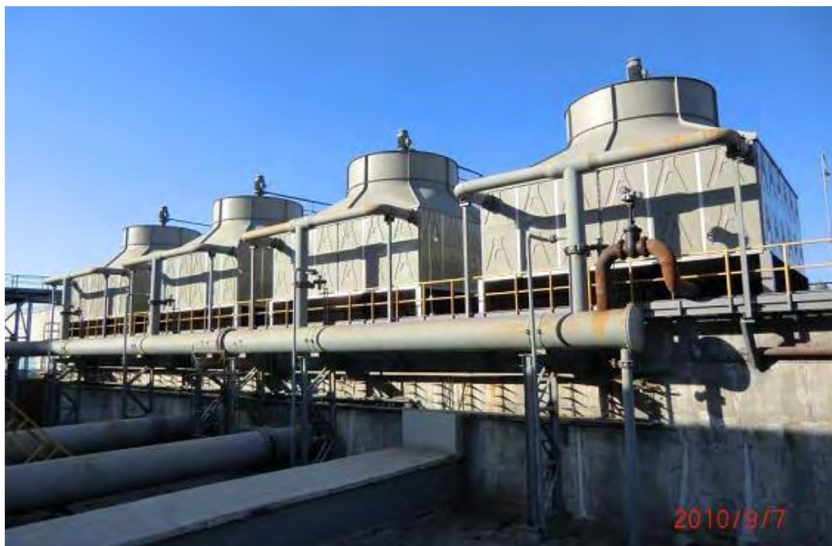
Mynd 8: Kæliturnar með kæliviftum (Mynd SMS Siemag).
