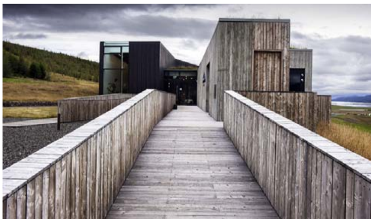
Snæfellsstofa á Skriðuklaustri hlaut vistvæna vottun fyrir fullbúna byggingu skv. BREEAM-vottunarkerfinu. EFLA sá um ráðgjöf verkefnisins.
